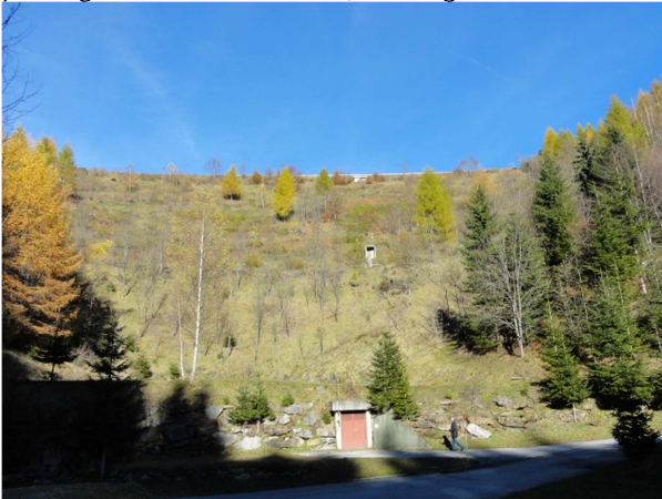
Slika 1. Pogled proti pregradi Golica z dolvodne strani
