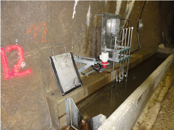
Slika 3. Meritev pretoka vode iz drenaže
