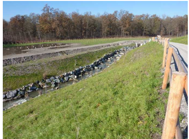
Slika 6: Ribja steza na HE Goessendorf na območju zasutega obtočnega kanala
