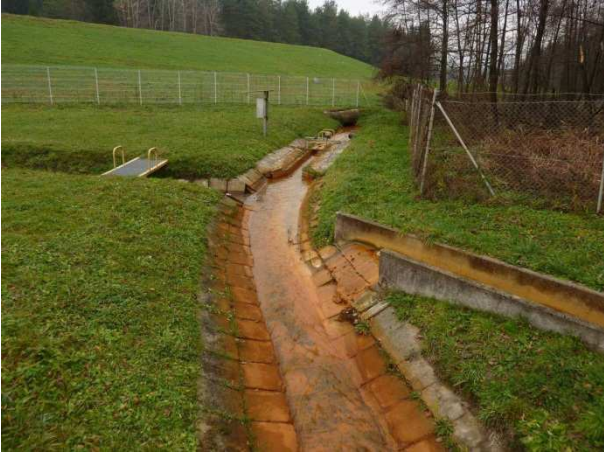
Slika 4: Stična točka drenažnih kanalov, v ozadju avtomatski merilec pretoka.
