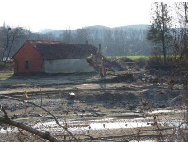
Slika 6: Porušeni objekt na vodni poti.
