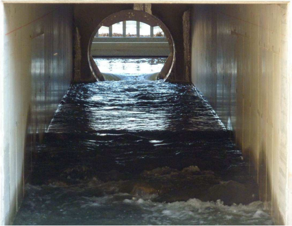
Slika 10: Temeljni izpust pregrade Schoekelbach – Weinitzen II.
