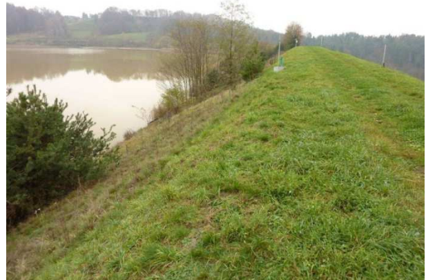
Slika 1: Gorvodno lice in krona pregrade.
