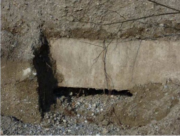
Slika 4: Nepravilnost – diskontinuiteta diafragme.
