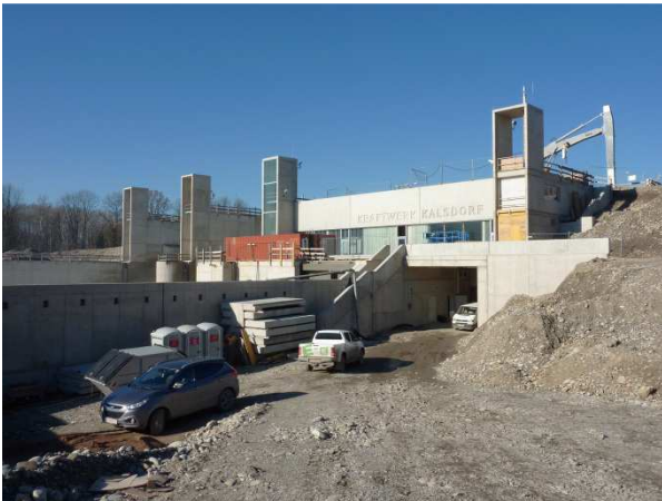
Slika 8: HE Kalsdorf (v gradnji)
