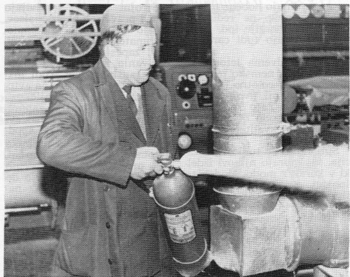
Na predavanjih je bil prikazan tudi način gašenja z aparatom CO_2 na razpršilec.
