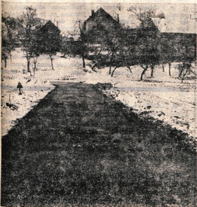
Del asfaltirane ceste pred Olševkom — Foto: F. Perdan
