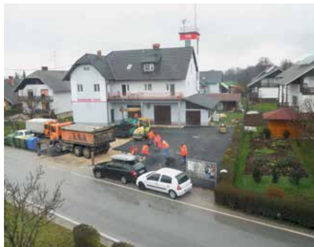
Asfaltiranje dvorišča leta 2015.
