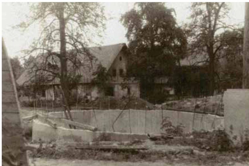
Gradnja požarnega bazena v Hrašah, 1980.
