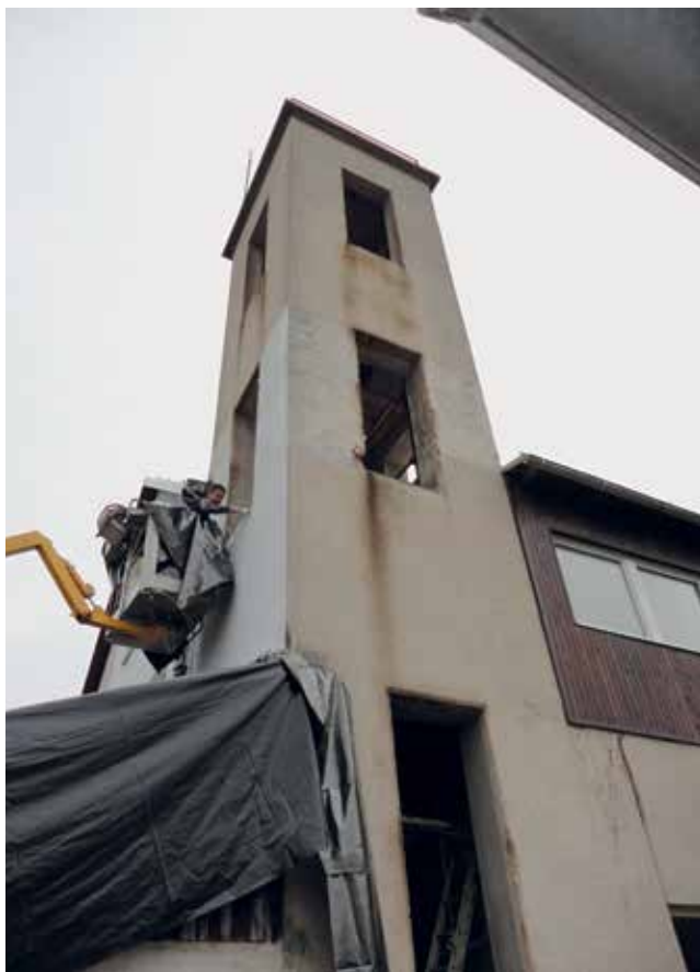
Obnova stolpa doma leta 2013.
