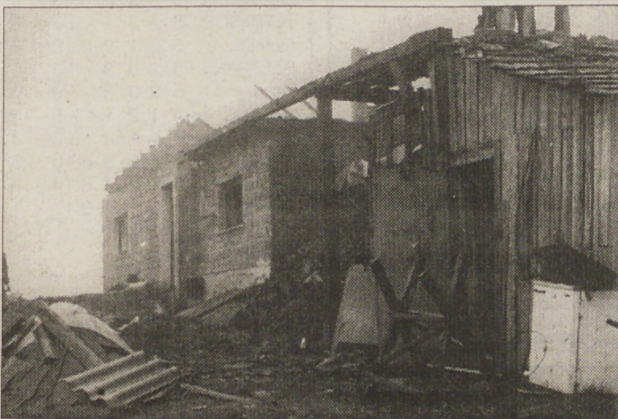
Od zidanega dela stanovanjske hiše, na kateri so nameravali na spomlad urediti pročelje, so ostale le stene. Ker je bil strop lesen, je zgorel tudi on, prav tako vse pohištvo, obleke, oprema ...
