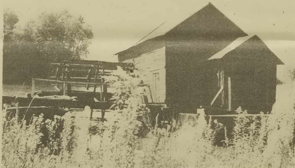
Kolesa murskih mlinov nekoč niso poganjala le mlinskih valjev, ampak marsikje tudi generator.
