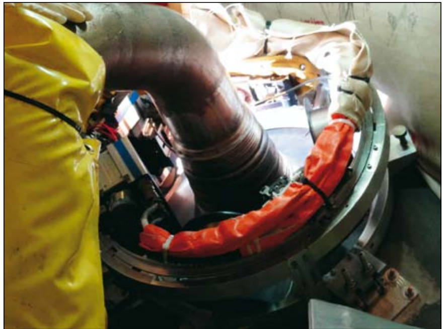
Konstruktivno navarjanje tlačnika ( AREVA – NUMIP ) – NE Krško
