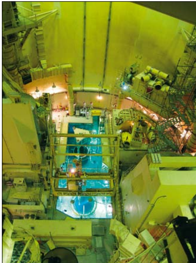
Odpiranje/zapiranje reaktorja – reaktorska stavba – NE Krško
