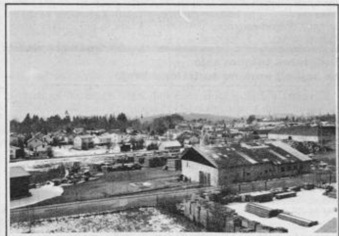
Nekdanja Kuharičeva žaga v Ormožu, ki pa je sedaj last ljutomerskega podjetja Murales. (Foto: S. Hozyan)
