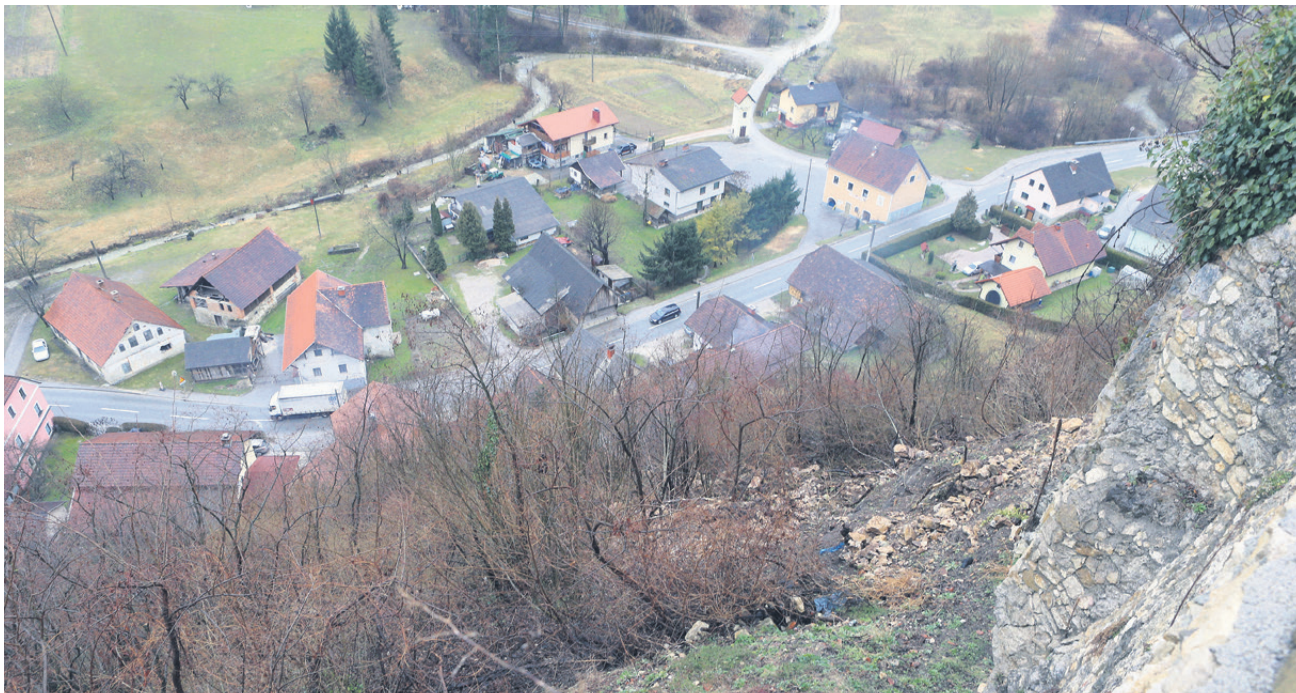
Celovita sanacije brežine pod gradom Lemberg bo stala od sto do dvesto tisoč evrov.
