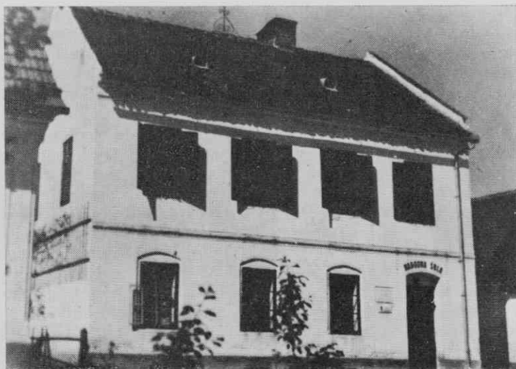
Vitomarci (Sv. Andraž v Slovenskih goricah), šola, zgrajena leta 1864, dozidana 1888 in popravljena 1894
