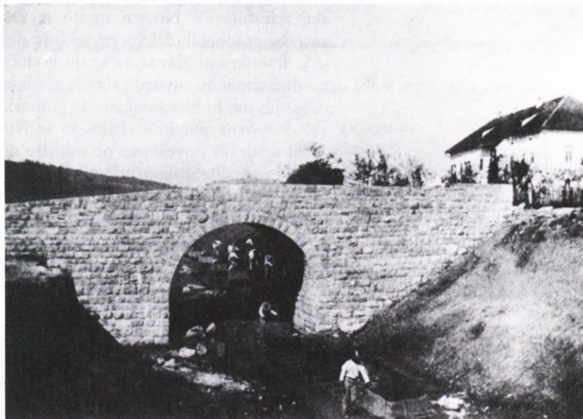
Gradnja železniškega nadvoza v Trebnjem 1893; fotoarhiv Knjižnice Mirana Jarca Novo mesto
