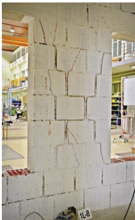
Slika 12 • Med preiskavo trietažne strižne stene ni bilo opaziti znakov vrtenja osrednjega zidu. Slika kaže poškodbe, nastale pri etažnem zasuku v velikosti 0,25 % etažne višine, že po doseženi maksimalni odpornosti (Triller, 2016). (Fotografija: Arhiv ZAG)
