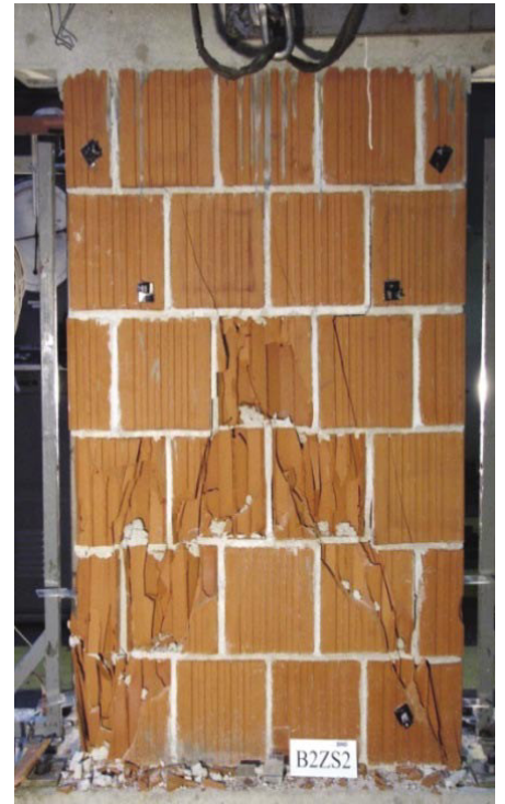
Slika 8 • Čeprav se je zid strižno porušil, so se v začetnih fazah preiskave zaradi njegovega vrtenja začeli drobiti zidaki v tlačnih vogalih (Tomaževič, 2012). (Fotografija: Arhiv ZAG)
