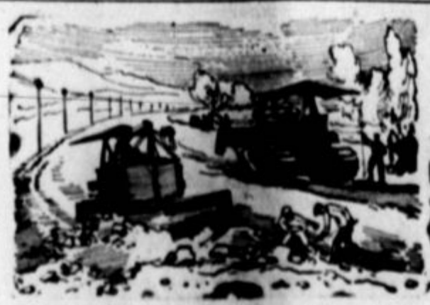
Buldozerji pri gradnji ceste Ljubljana-Trst
