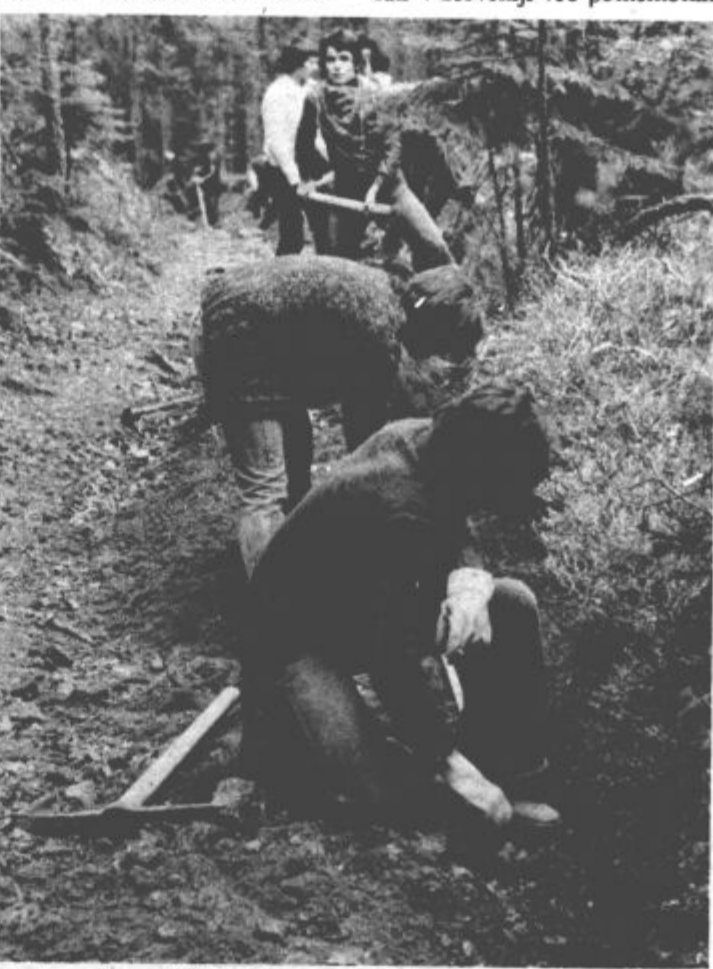
V soboto in nedeljo je bila v Zavodnjah lokalna mladinska delovna akcija, ki se jo je udeležilo 75 mladink in mladincev iz OO ZSMS Velenje. Pod vodstvom Toneta Žižmonda so skopali 4500 m jarka za vodovod in položili 3000 metrov cevi.
