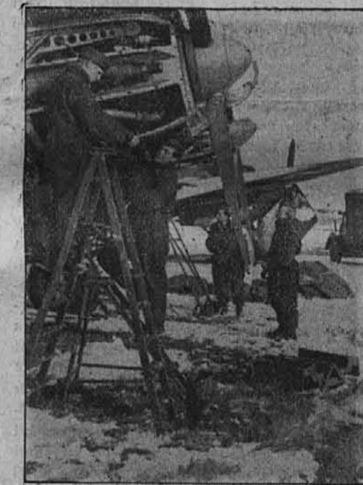
Letalske poljske delavnice na kolesih. Vojaki poljske letalske delavnice pri popraviljanju letalskih motorjev.
