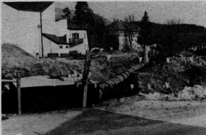
Dela na kolektorju v Nazarjah
