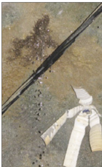
Luknja v stropu, od koder pušča voda, tla v tunelu so stalno mokra
