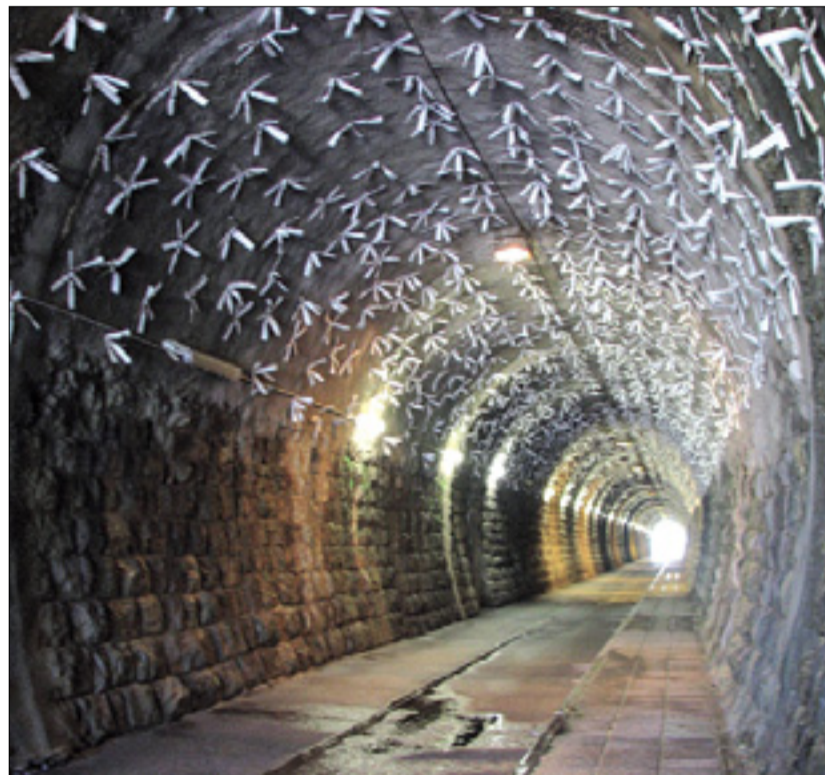
Luknja v stropu, od koder pušča voda, tla v tunelu so stalno mokra
