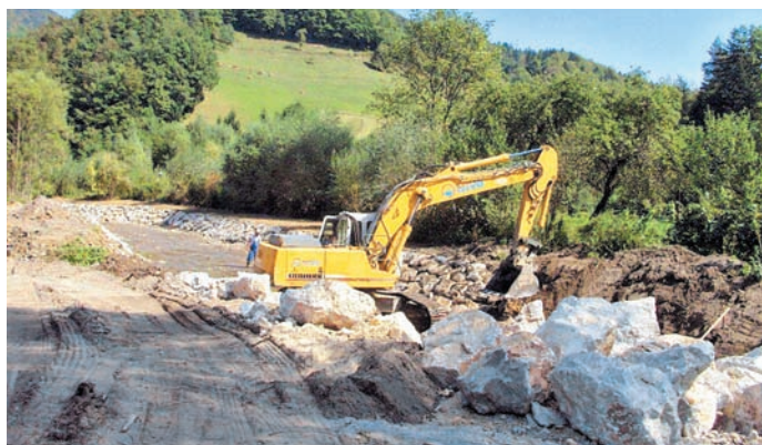
Dela na Motnišnici v Zg. Motniku.
