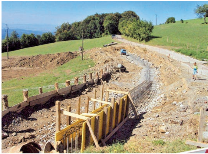
Mali Rakitovec - izgradnja opornega zidu.
