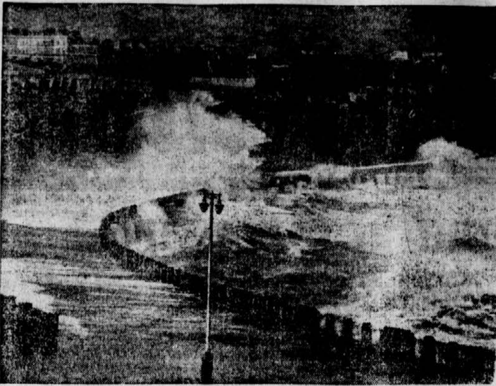
Mächtige Wellen branden an der Ufermauer der Stadt Douglas auf der Insel Man empor und hüllen die Promenade in eine Wolke von sprühendem Wasser. (Deutsche Presse-Photo-Zentrale-M.)
