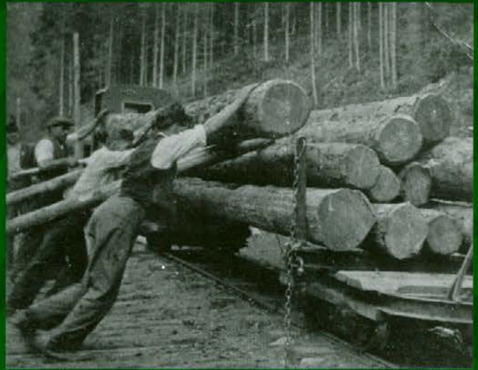
Prizor nakladanja na vagon mislinjske gozdne železnice
