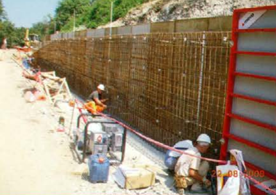
Oporni zid Reš v Radljah ob Dravi
