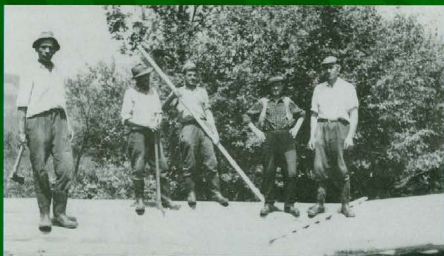
Priprava cestišča za asfalt leta 1965
