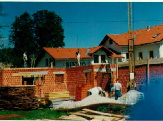
Začetek gradnje novih poslovnih prostorov zadruge Ledina
