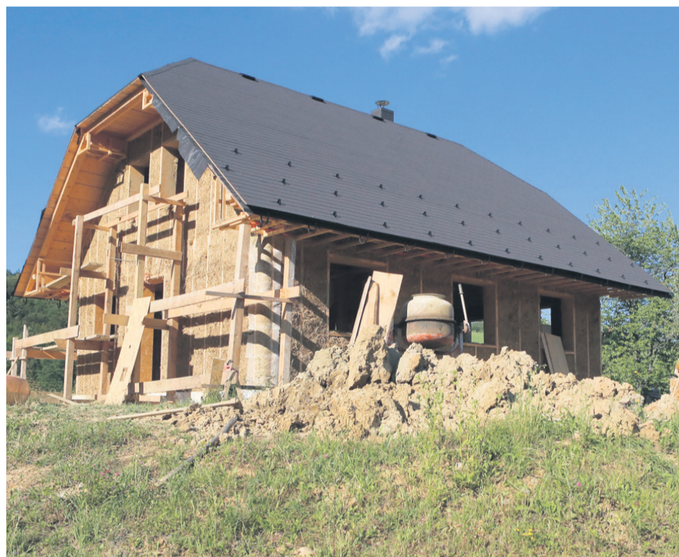
Hiša je prekrita s tegolo, kar je samo začasna rešitev. »Ko bova menjala streho, bova novo naredila iz slame. Ampak trenutno si tega ne moreva privoščiti. Verjetno bo najbolje, da si bova strešno slamo – škop – vzgojila in pripravila kar sama.«
