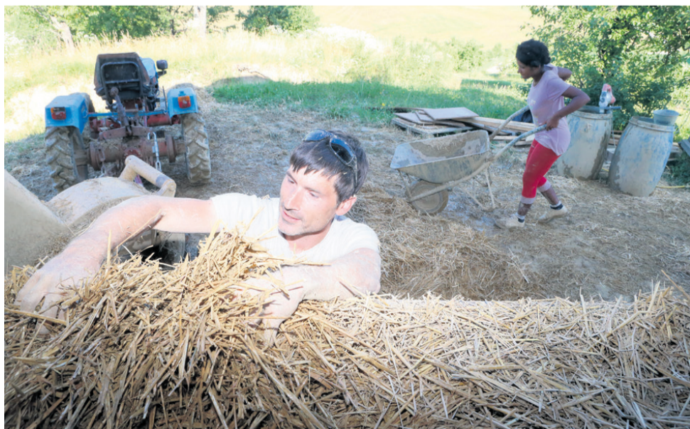
Leseno konstrukcijo so napolnili z zrezano slamo, premešano z glineno vodo. Ko se bo zmes strdila, jo bodo na zunanji strani ometali z običajnimi ometi in s fasadnim zaključnim slojem, medtem ko bodo na notranji strani zidovi iz ilovice, prebeljeni z apnom.
