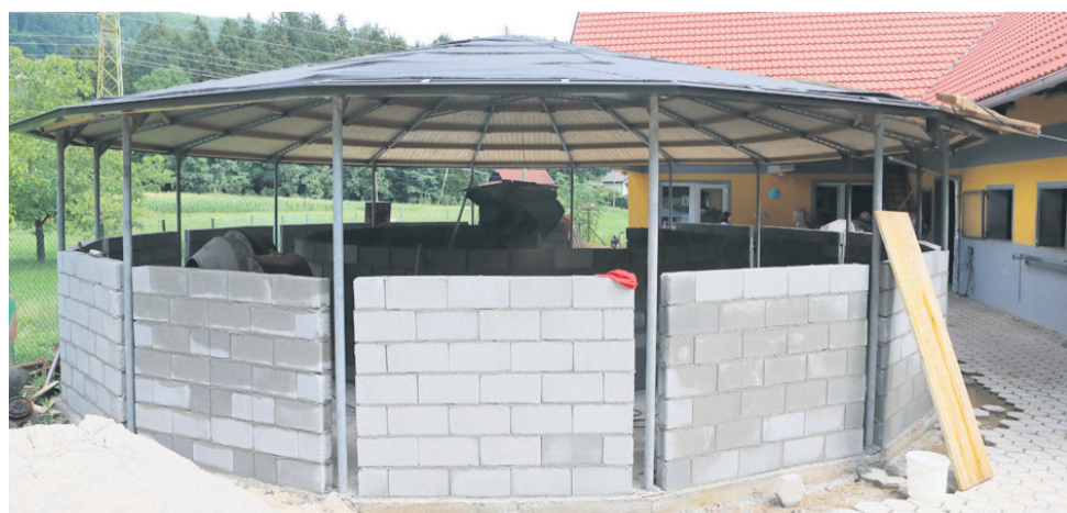
Pokrita sprehajalna naprava v gradnji
