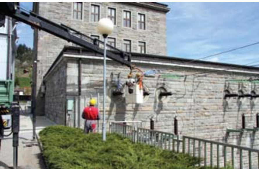
Zamenjava izolatorjev na HE Mariborski otok.
