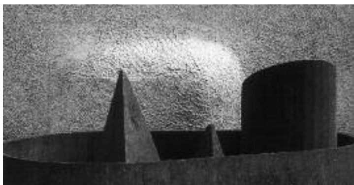
slika 6: Vodni rezervoar iz betona, vlitega s tehniko béton brut , kapela Notre Dame du Haut, Ronchamp, Le Corbusier, 1950
