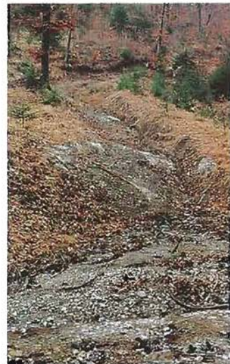
Slika 2: Gozdna vlaka na občutljivi podlagi - pretnja progresivne erozije Figure 2: Skidroad on sensitive bedrock - threat of progressive erosion
