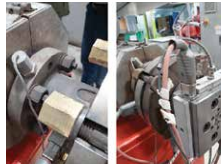
Namestitev novih senzorjev za vibracije na ekstruzijsko linijo.
