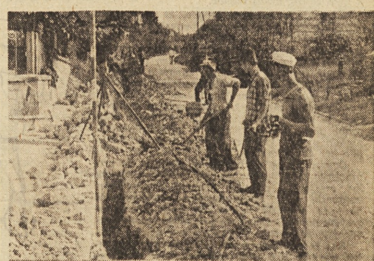
Pravilo, da bo novo poštno poslopje na Novem trgu v Novem mestu gotovo že letos. Najbolj veseli pa bodo Dolenjci tega, da bodo v tem posloplu dobili tudi avtomatsko telefonsko centralo. Delavci Tagrada iz Ljubljane so v teh dneh namreč že položili telefonski kabel.
