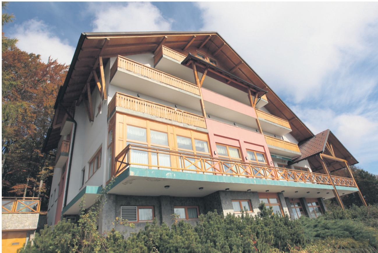
Po vrsti neuspešnih dražb objekt – veljal je za turistični up tako nekoč kot danes – naposled kupuje štorska občina.
