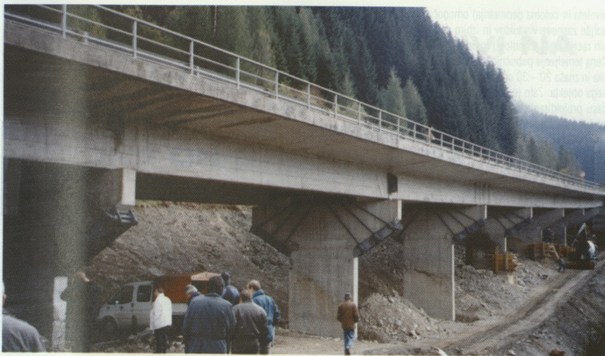
Slika 24: Viadukt na cesti B 115 v Avstriji med sanacijo poškodb zaradi plazjenja tal
