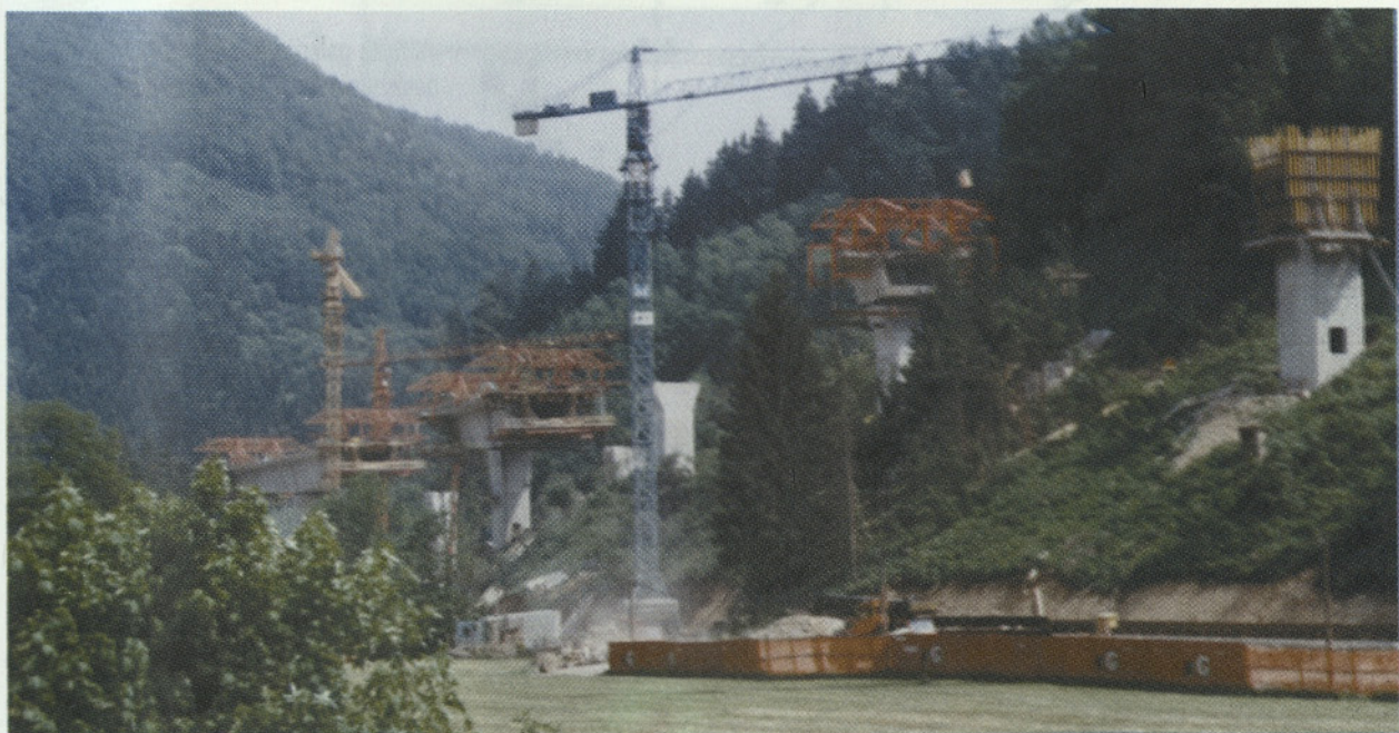
Slika 16: Del viadukta Ločica med gradnjo, maj 2000
