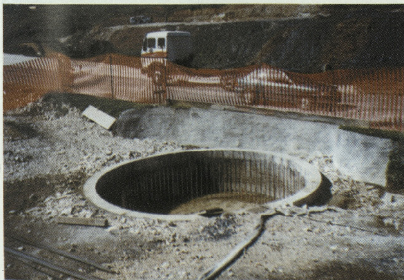
Slika 9: Vodnjak na ravnem terenu premera 6,0 m, višine 6 – 8 m, varovan z armiranim torkret betonom debeline 10 – 15 cm in armiranobetonskim prstanom na vrhu vodnjaka, uporabljen na viaduktih Zlokarje in Črni mlinar - Trojane
