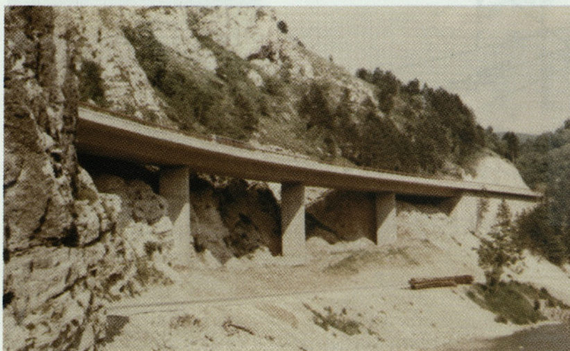
Slika 23: Pobočni viadukt na magistralni cesti Sarajevo - Pale
