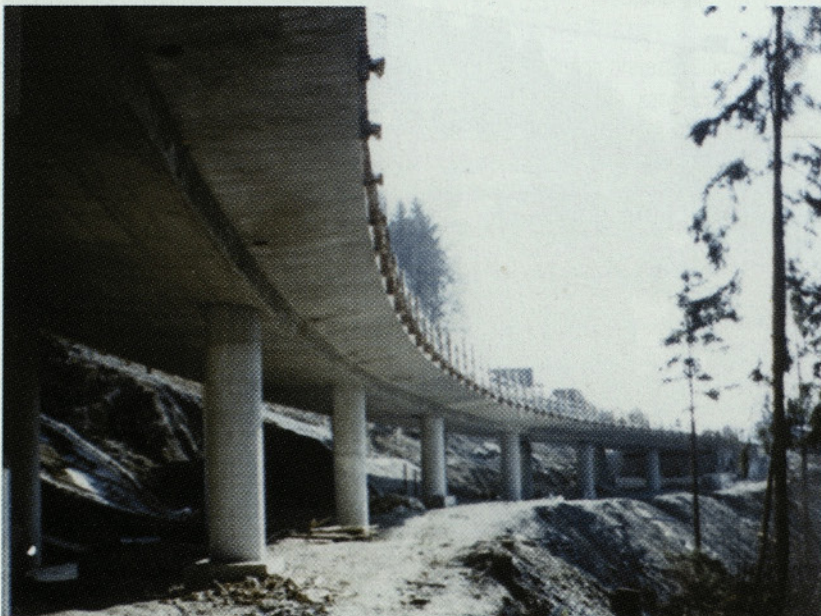
Slika 19: Pobočni viadukt v Zideh (Trojane)
