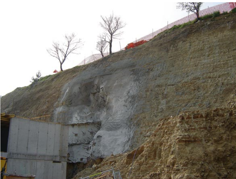
Slika 20. Na levi strani gradnja bloka »B« in saniran hribinski podor ob prelomni in oslabljeni coni, na desni strani izkop pod rezervoarji Rižanskega vodovoda v območju objekta »AB«.
