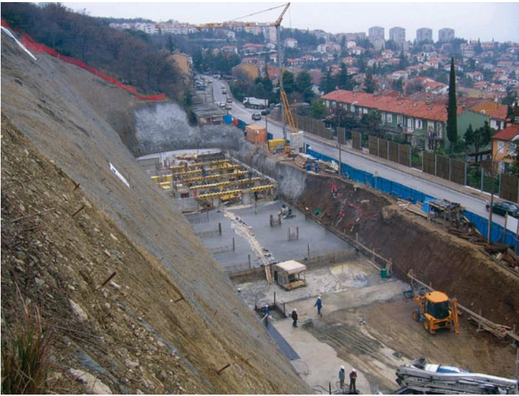
Slika 19. Pogled na dokončno izkopano brežino objektov A1 in A2, varovano s pasivnimi samovrtalnimi injektirnimi sidri do dna druge kletne etaže – podzemne garaže, kjer poteka izvedba temeljenja in opaženja prvih spodnjih sten (december 2006).
