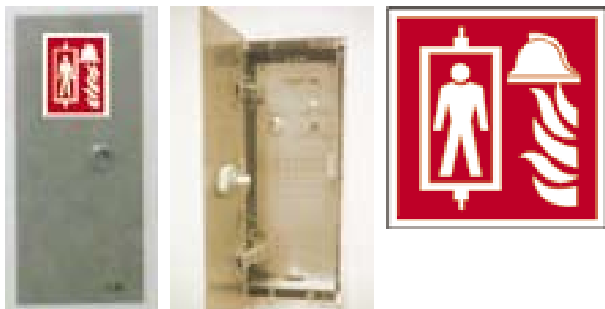
Slika 8. Namestitve in označitev omarice s stikalom za gasilce
