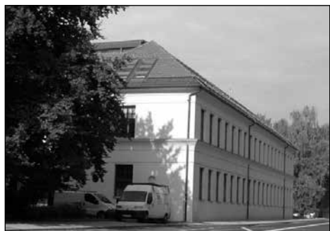
Stavba "stara tehnika" na Aškerčevi cesti v Ljubljani.
