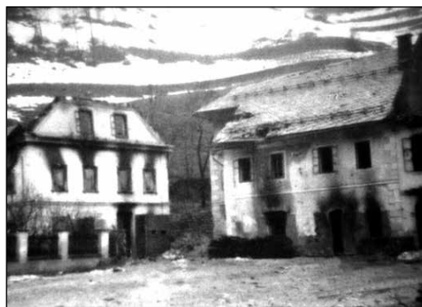
Požgano župnišče in desno Štrbencova hiša, v ozadju zasneženi hrib Strmica.
