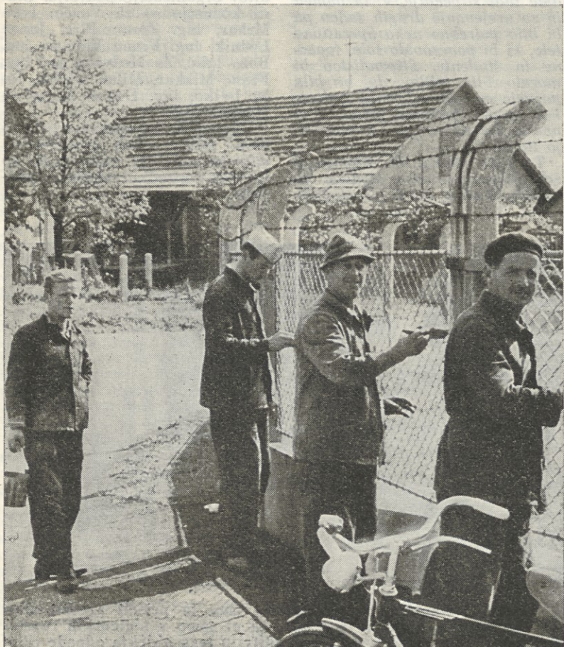
Posnetek prikazuje vso »posadko« naše medvoške plesarske delavnice pri pleskanju ograje ob vratarnici
