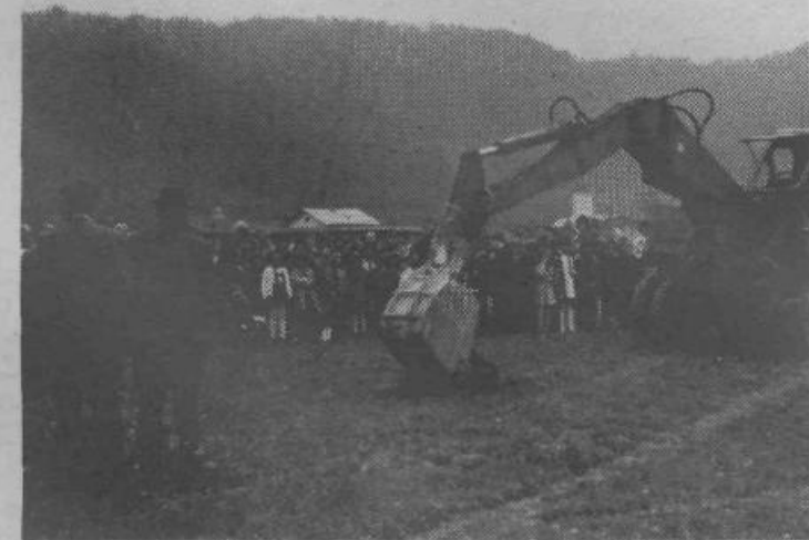
Takole je moderni »kramp« prvič zasadil svoje zobe v ledino za prvo šolo v naši občini zgrajeno iz samoprispevka
