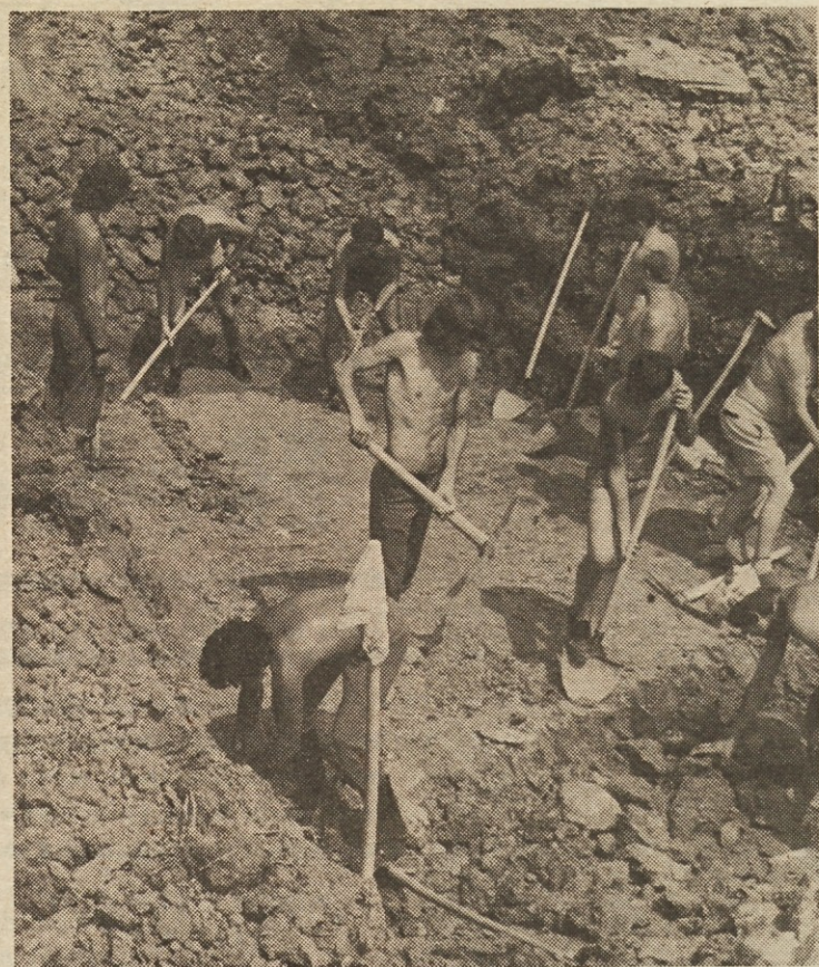
„Skoraj tretjina delavcev našega podjetja je danes tukaj,“ so zagotovili delavci Toplovoda iz Velenja. „Na zboru delovne skupnosti smo tudi sklenili, da bomo centralno kurjavo v šoli naredili udarniško.“
