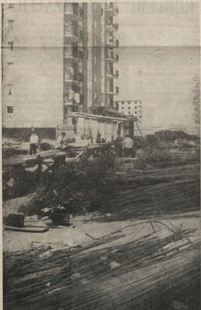
Na vogalu Kajuhove in Zaloške ceste je še vedno kup železja, ki ga delavci kar tukaj krivijo za gradbene potrebe, okoliški stanovalci se sprašujejo, kdaj bo ta prostor urejen
