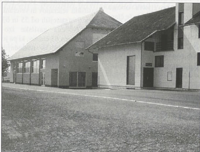
Nova dvorana meri 653 kvadratnih metrov. Od tega je 433 kvadratnih metrov telovadnih površin.
