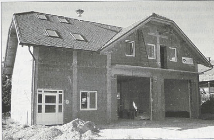
Gasilski dom Nova vas je zgrajen.
