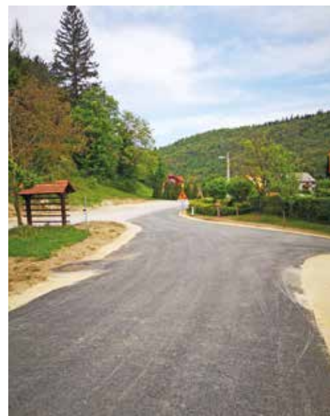
Del Iške dobil kanalizacijo in obnovljen vodovod
