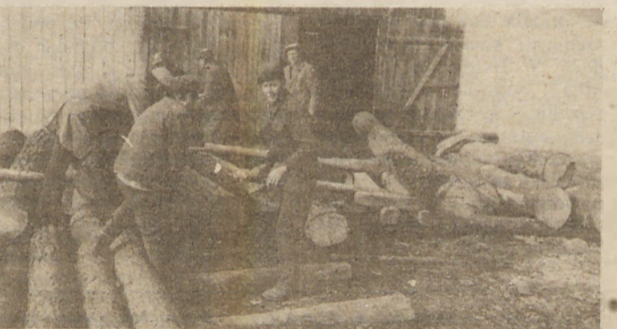
Bivšo šolo v Šulincih, ki jo uporabljajo za sestanke, prireditve in veselice, je močno načel zob časa, posebno ostrešje. Odločili so se za obnovitev in zbrali precej lesa. Na sliki vidimo nekatere vaščane med pripravo lesa za žaganje. Foto: Milan Gašpar
