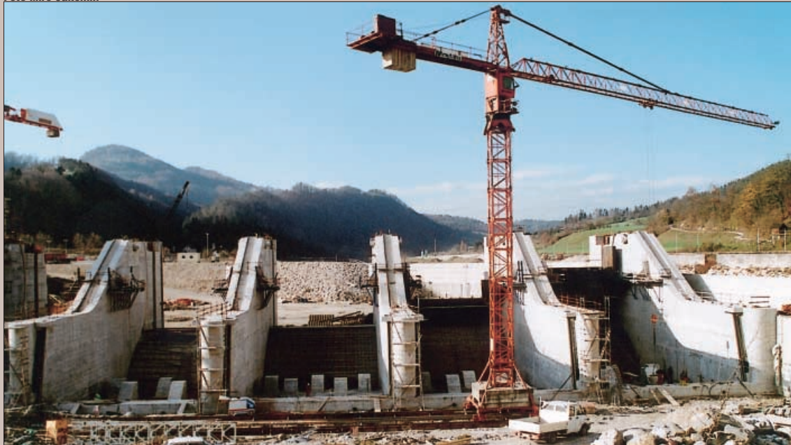
Del gradbišča HE Boštanj.
