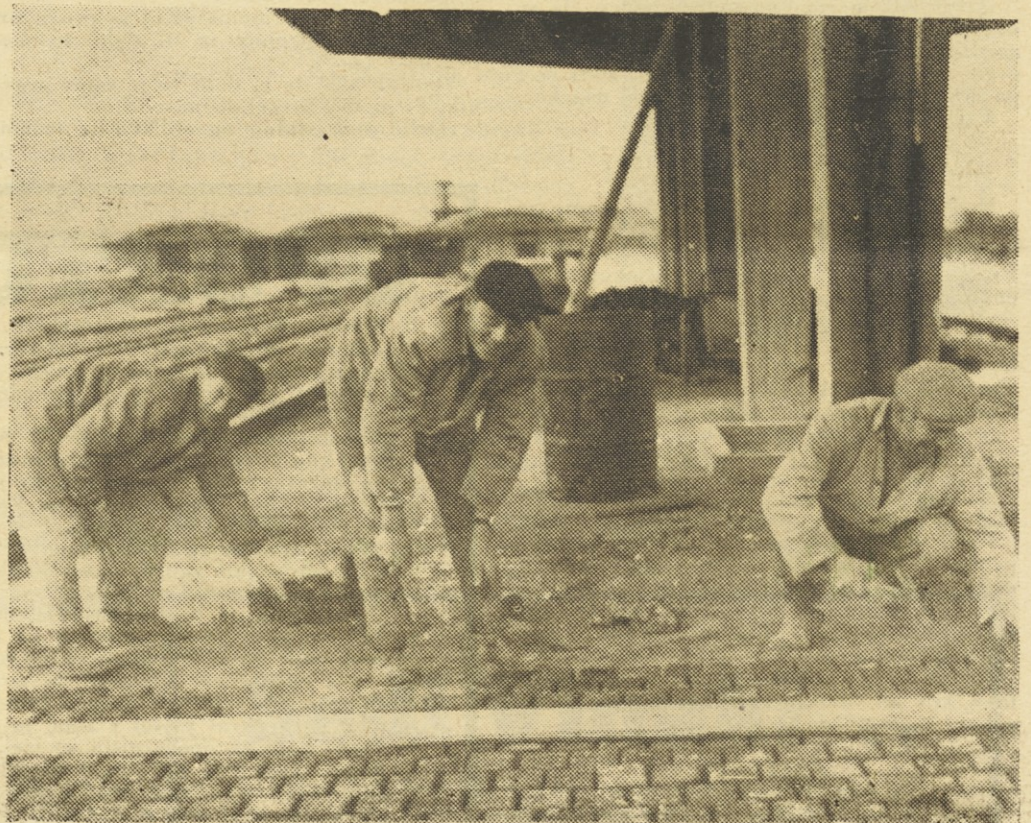
Tovariši Jože Marič, Karel Mencinger in Milan Džuras pri flakovanju skladišča vnetljivih tekočin na gradbišču Moste
