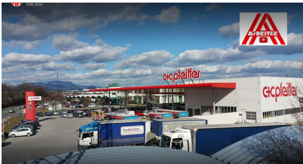
Slika 14: C+C Pfeiffer logistični, skladiščni in prodajni center v Grazu s 60.000 m2 celotnih površin (vir: http://www.ccpfeiffer.at/ , 10.11.2016)
