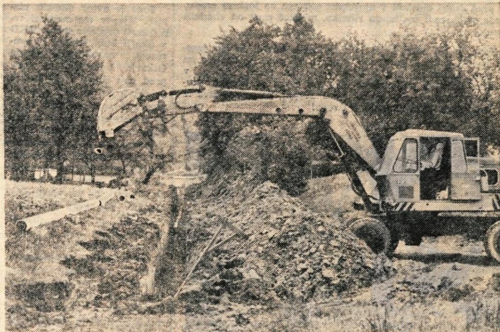
Minuli teder so v Stražišču začeli z izkopom za glavni cevovod proti Žabnici — Foto: F. Perdan
