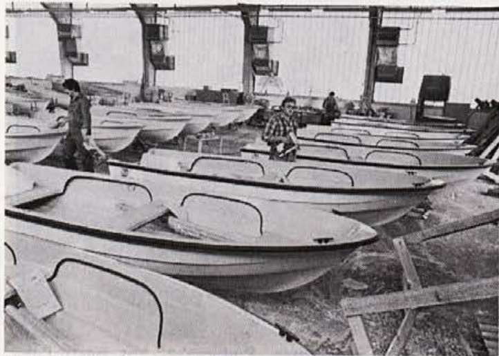
Zadnji prijemi pri montaži čolnov T 401
