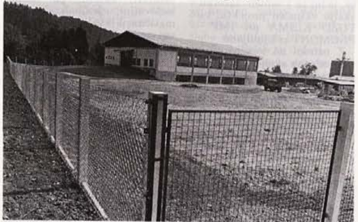
Nova ograja in skladišče telovadnega orodja
