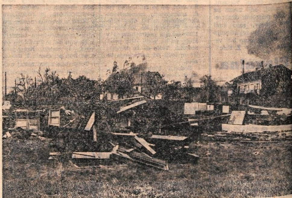
Pred kratkim so na Javorniku podrli del Projektovega naselja. — Foto: F. Perdan
