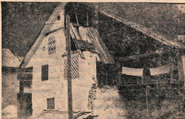
Škoda, ki jo je povzročila narasla Sora v letu 1966 ob Dermotovem jezju je v glavnem v celoti odpravljena, le ta sosednji objekt čaka še danes na popravilo ter kazni videz naselju. — A. Sedej
