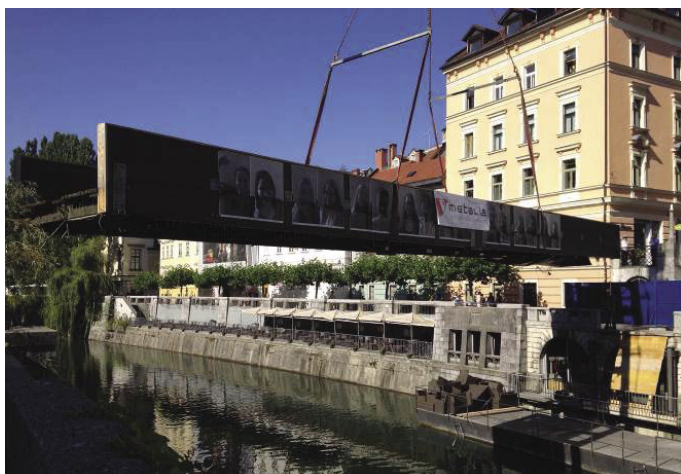
Slika 23 • Odstranitev dotrajane brvi (levo) in izvedba podporne konstrukcije za novo brv (desno)
