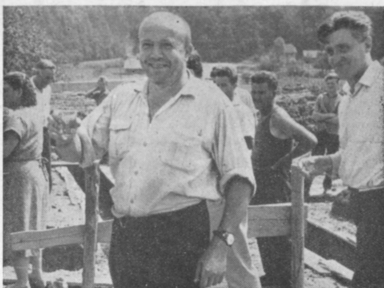
Podpredsednik šmarske občine Lojze Krivec, predsednik KLO Jaka Leskovšek in šolska upraviteljica Adela Ravter na gradbišču osnovne šole v Lesičnem.
