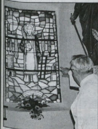
Župnik Šolinc kaže poškodovan stekleni mozaik.
