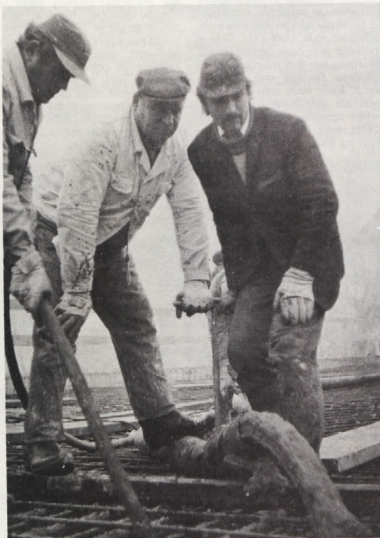
Betoniranje na mostu v Dobovi pri Brezicah, ki ga gradi TOZD gradbeni sektor Krško
