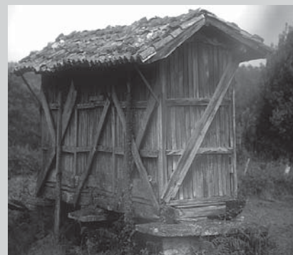
□ Slika 5. Horreo: posebnost je postavitve tudi v obmorskih krajih, postavitve horreov v vrste, uporaba lesa v kombinaciji s konstrukcijo iz kamna.
