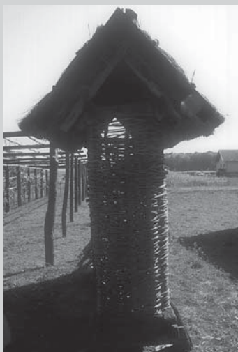
□ Slika 9. Koruznjak v prepletu, SV Slovenija, danes za Dominkovo domačijo v Gorišnici: gre za ponovitev horrea, le da je zaradi večje uporabne vrednosti podaljšan – tako rekoč je sestav prerezanega kroga, z vmesnim ortogonalnim delom.
