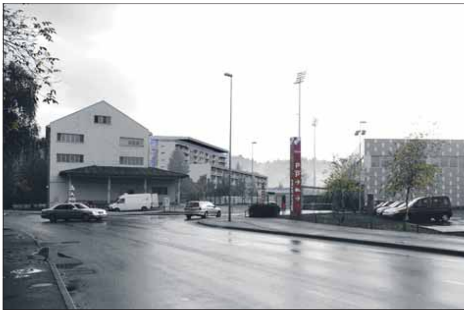
Pogled na Dom starejših s križišča
