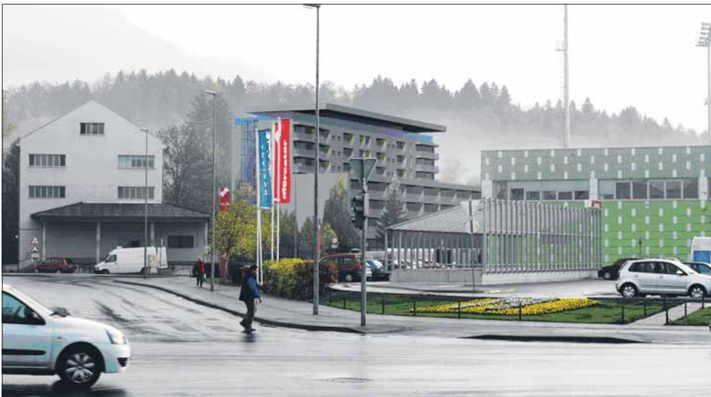
Pogled na Dom starejših s severne strani, s Ceste talcev
